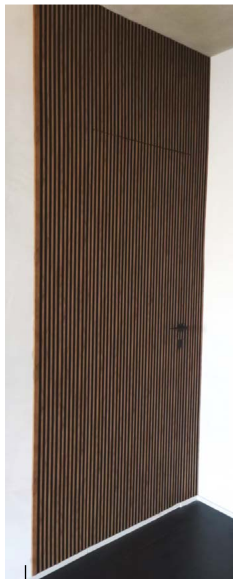
Rivestimento porte e mobili
